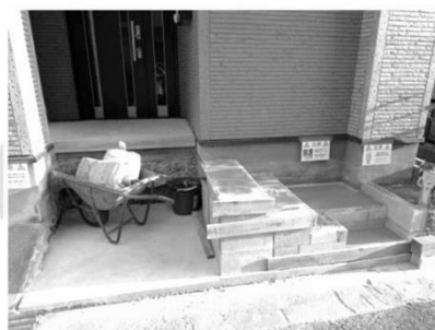
④階段部分のコンクリート打設終了 次はポケサボカラーのタイル貼り
