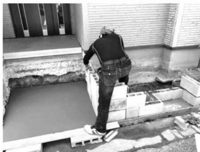
②新しい階段の組み上げと 昇降機設置スペースの確保
