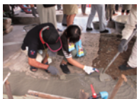
段差をなおすボランティア
