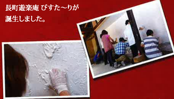
これからもこの古民家が、120年後も存在しますようにと願いを込めて漆喰をスタッフで塗り直しました。
