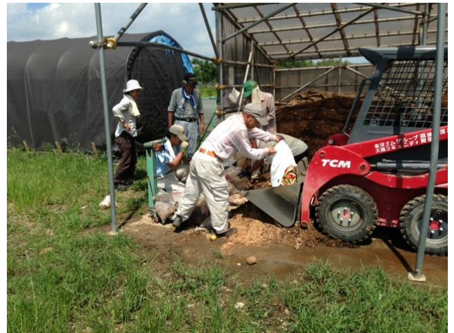
生ごみ2次処理状況
