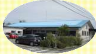
20年ぶりに屋根と外壁の塗り替え
