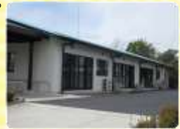
北側の駐車場も舗装しました。
