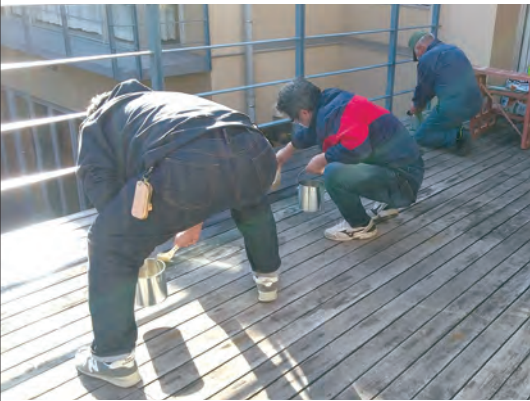
ウッドデッキの塗り替えをしている様子
