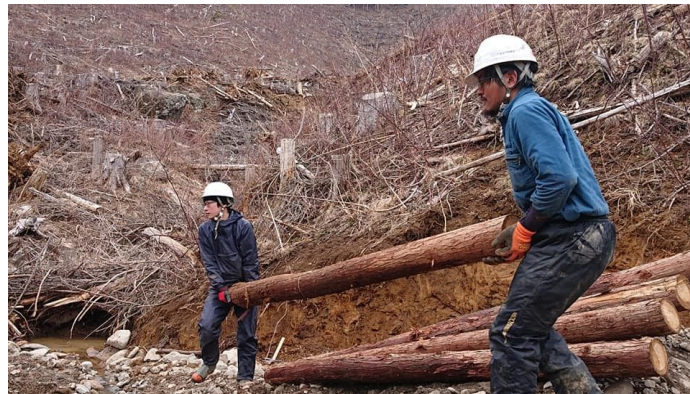
写真 木組み施業作業
