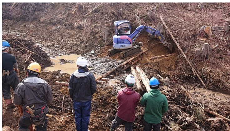
写真 谷渡り（洗い越し）施工作業
