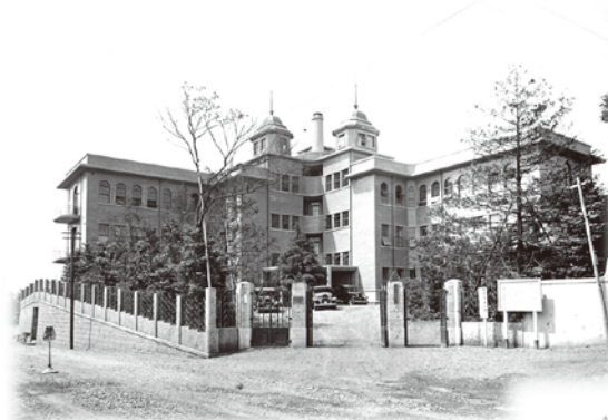
国際聖母病院 鉄筋コンクリート3階建 (1931年) 東京
