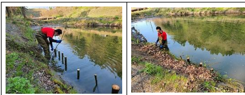
ヤナギの枝を杭に絡めて土留めとする柳枝工で実施
