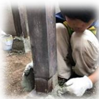
民家修繕DIY
