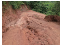
タンザニア：施工前
