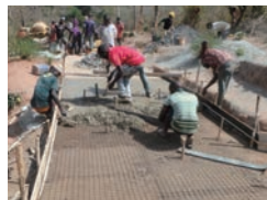
タンザニア：施工中
