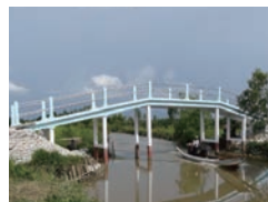
ミャンマー： 施工後
