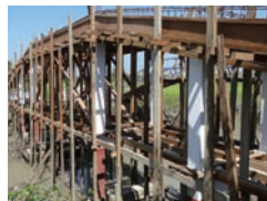
ミャンマー： 施工の様子
