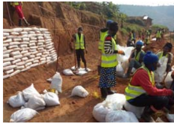
ンゴロレロ郡でのパイロット施工
