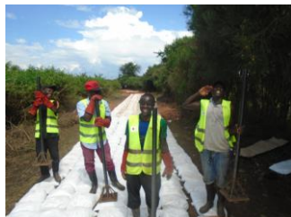
カセセ県での土のう工法研修
