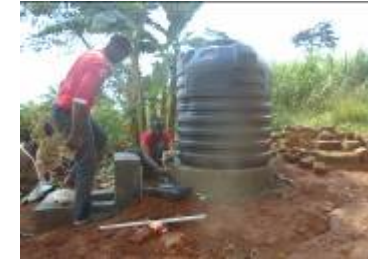
ジンガ島での給水タンク設置
