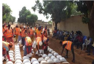
土のう工法研修（デモ見学）
