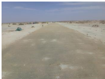
整備後の道路(延長360m)
