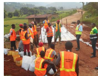
若者組合によるデモ施工と、運輸開発庁の技官による出来形確認
