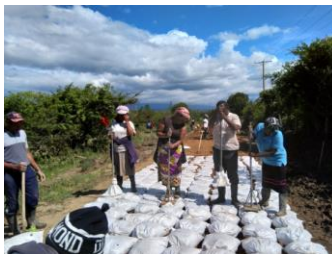
農民グループとの林道整備
