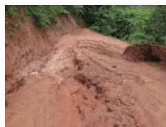
タンザニア：施工前
