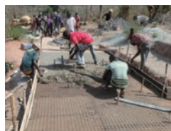
タンザニア：施工中
