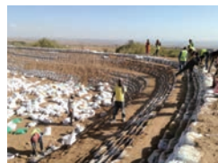
エチオピア： 土のうを用いたため池建設
