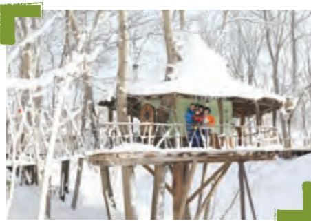
吊り橋付ツリーハウスの定期改修
