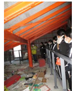
震災遺構・中浜小学校見学 子どもたちが一夜を過ごした屋根裏部屋
