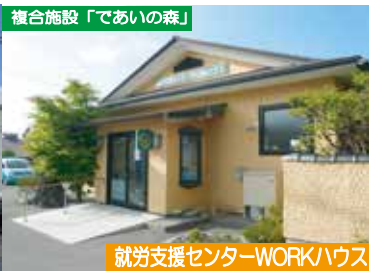
就労支援センターWORKハウス
