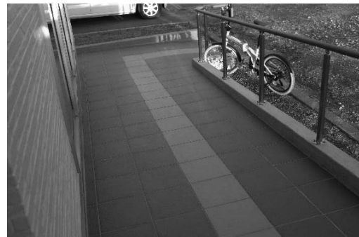
スロープの舗装
