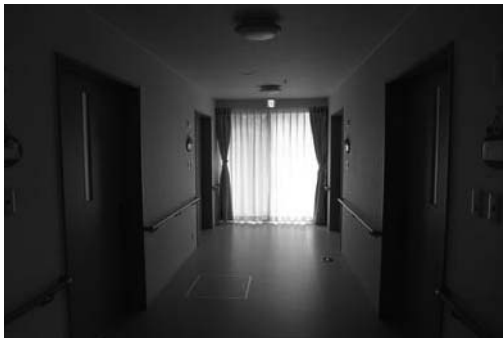
廊下は約 2.5mの通路幅を確保
