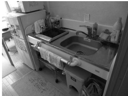
キッチンの手すり設置状況
