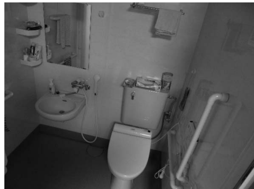
居室内トイレ（シャワーが設置）
