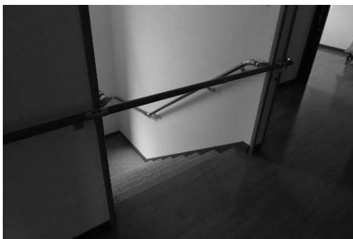
階段（転落防止バー）
