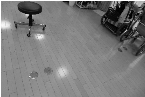
フロアコンセント設置状況
