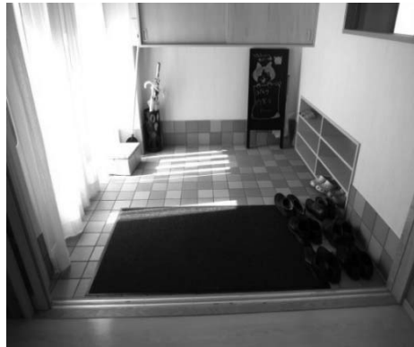
段差のない玄関
