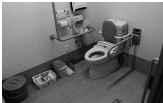
トイレ（手すりは木製）
