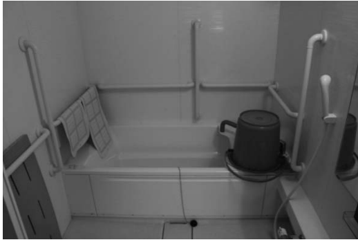
浴室（様々な方向に手すりが付いている）
