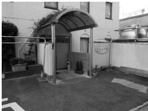
みなみかぜの玄関とスプリンクラー用タンク
