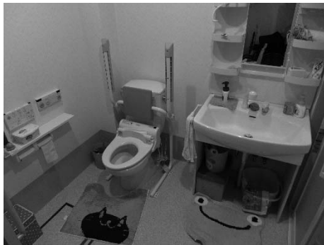
トイレ内（B）洗面台の高さを調整
