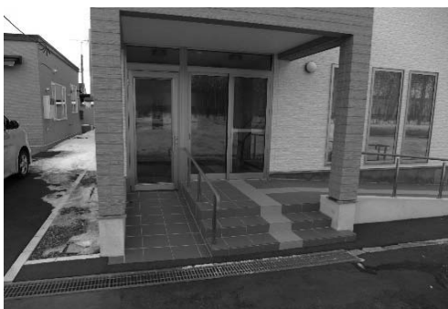
出入口の状況
