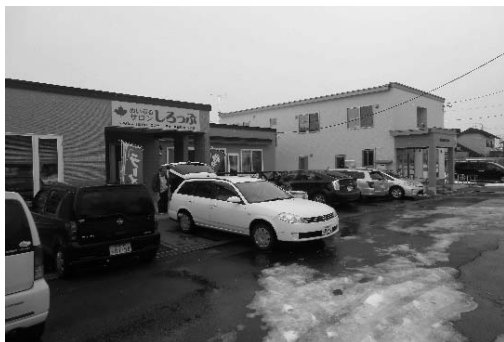
隣接する共生型サロンの外観
