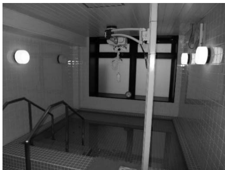
1階大浴場（リフターが設置）
