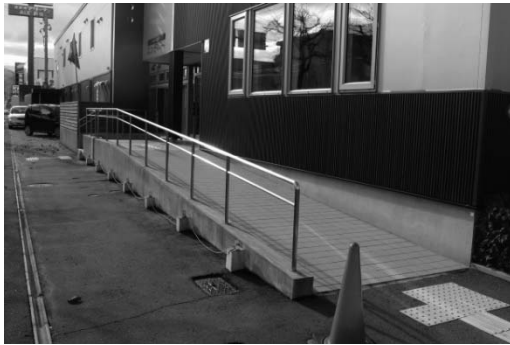
玄関部分のスロープ
