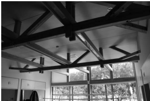
木製の梁と天井までのガラス窓
