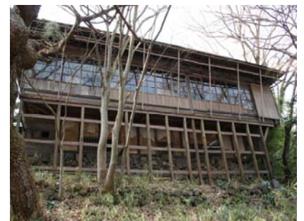
修繕工事完了
