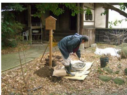
案内板設置工事状況
