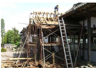
解体中の法蓮寺向拝(玄関)
