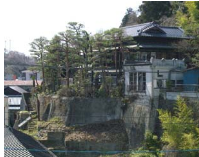
亀井邸整備後
