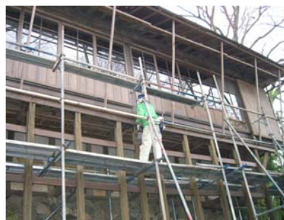
修繕工事状況
