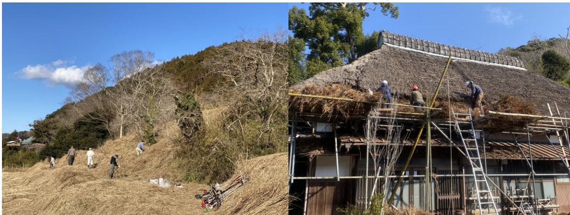
古民家ろくすけ 周辺環境整備カヤ刈り作業 母屋の屋根補修
