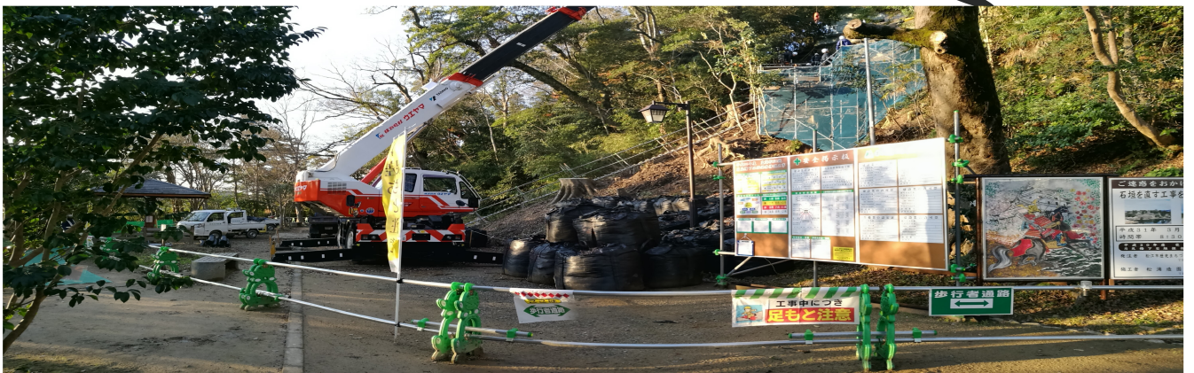
平成30年度史跡松江城月見櫓下石垣保存修復工事に看板が設置されたときの様子 (H30.12.12)
