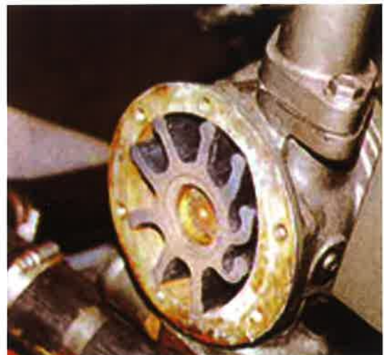
正常なインペラ 冷却水ポンプを開放した状態
