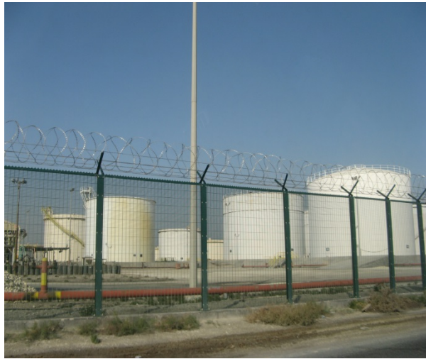
Khalifa Bin Salman 港近くの石油タンク
