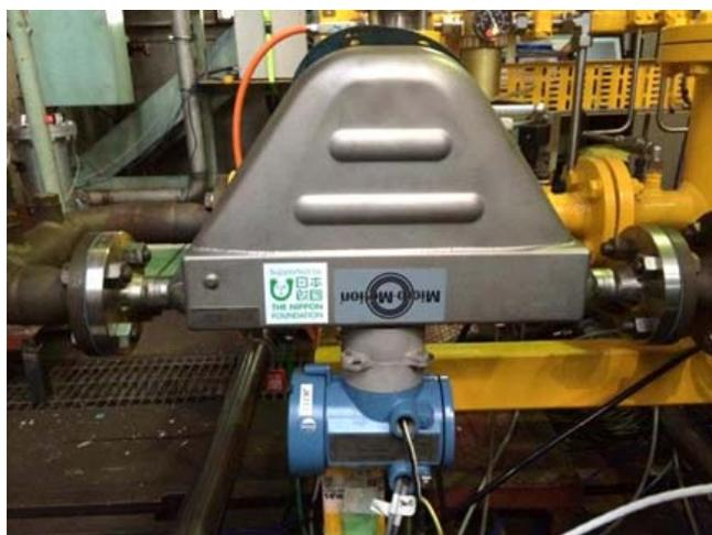
図 2-1-2-4 燃料ガス流量計
