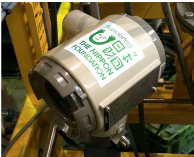
図 2-1-2-5 燃料ガス熱量計
