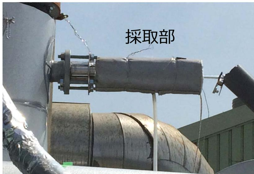
図75. 陸上試験におけるレーザ式分析計の採取部の状況
