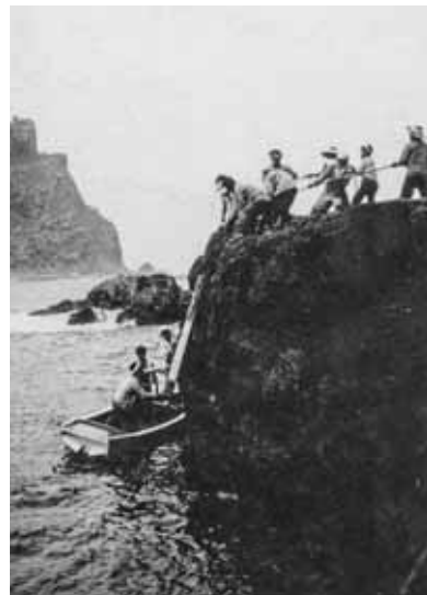
警告板を15メートルの断崖から陸揚げ
