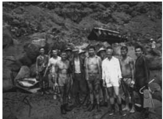
久場島で座礁船の解体作業している台湾人労働者、責任者を呼んで正規の手続きで入域勧告を行った
