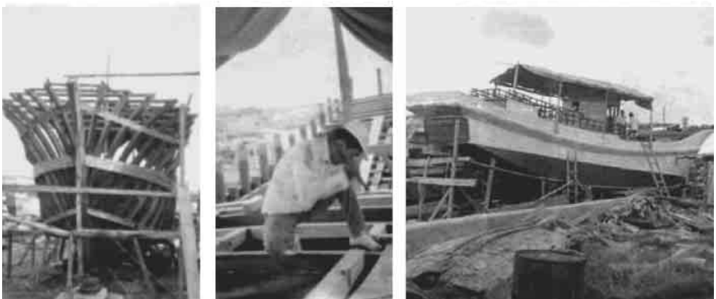
今でも木船造っている夢を見る。造船場で忙しく動き回っている途中でよく覚める。写真は徳豊丸(23ト)の造船光景(1969年) 左:船体肋骨組み、中央:1つ1つ骨組をていねいに仕上げる 右:船体仕上げ
