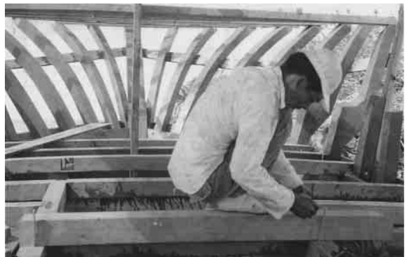
徳豊丸(23ト)の斜肋骨とビーム(梁)取付け。(1969年8月)
