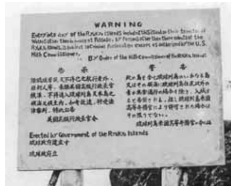
警告板は尖閣5島の7箇所海岸に設置。コンクリート製の大きな平板、(W120 x H90)、日・米・中の3ヶ国語で不法上陸を警告。(新納義馬,1971)
