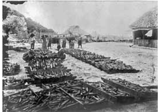
魚釣島でのカツオ節製造光景。島の周りでカツオ釣ると、島に水揚げしてカツオ節製造した。(明治43年)
