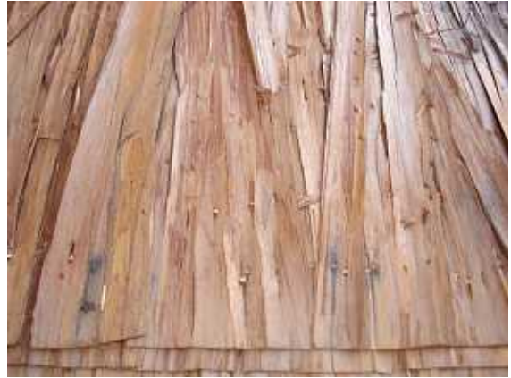
写真 29 : 檜皮葺きの模型と竹釘で打ち付けられた檜皮
