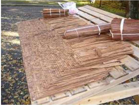
写真 29 : 檜皮葺きの模型と竹釘で打ち付けられた檜皮
