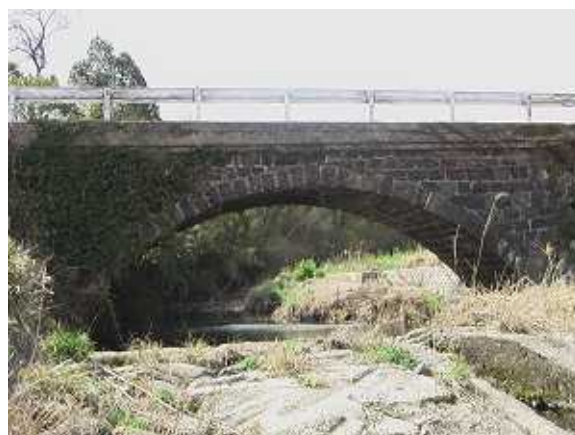
写真 95：石積みのアーチ橋
