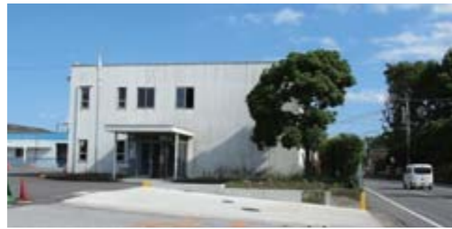
大分県水難救済会の事務局が入居する「鶴崎海陸運輸物流管理センター」
