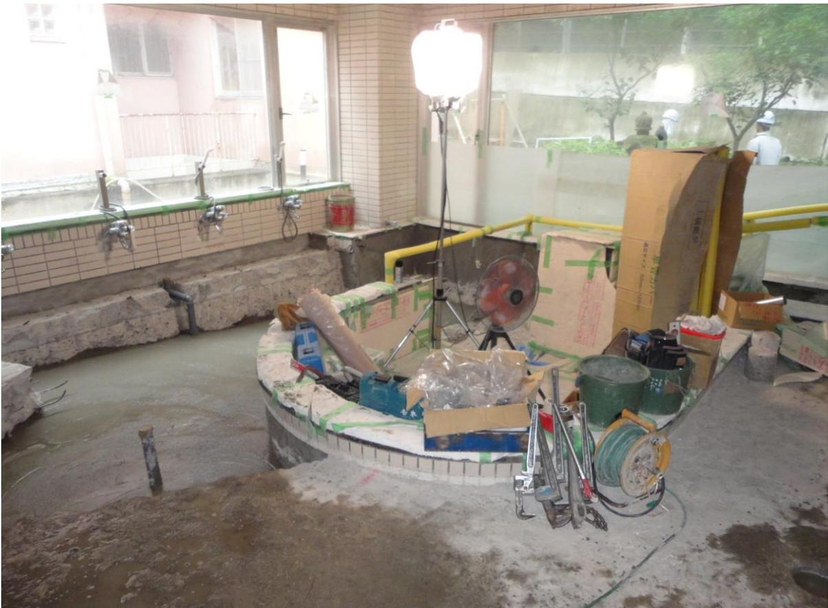
全体的に地盤沈下しており、地盤改良が必要となっています。
