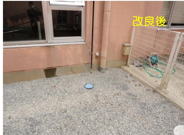
地盤沈下により、給湯管と排水管が地中内で破損していましたが、改修できました。
