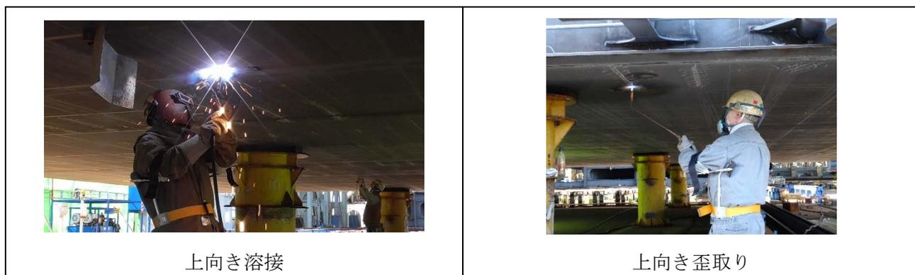
図 4.2 住友重機械マリンエンジニアリングでのタイプ A 一次試作機による実証試験
