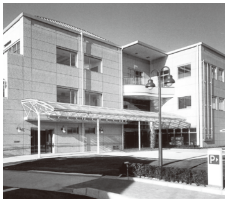
< 扶桑町総合福祉センター 外観 >
