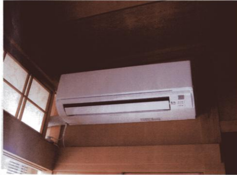
エアコン取付 面接室
