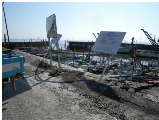
護岸が傾き、取り付け道路との間にすきまができた (行徳)
