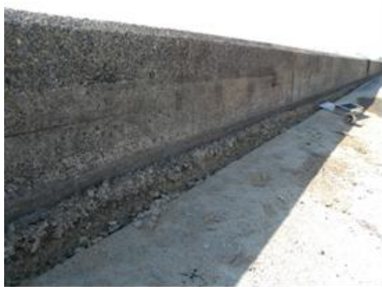
護岸が傾き、取り付け道路との間にすきまができた (行徳)
