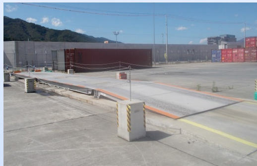
【トラックスケール】
