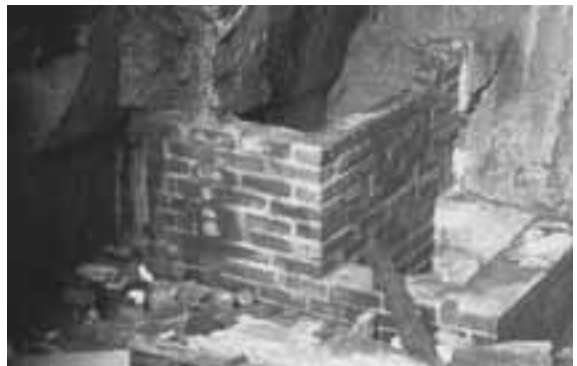
湧水がないため、レンガで貯水タンクが造られていたが、鳥糞が滲み出し飲める水ではなかった。（仲間均 2002）
