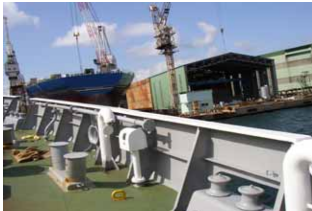
☆ブルワークトップ (塗装前の状態)
