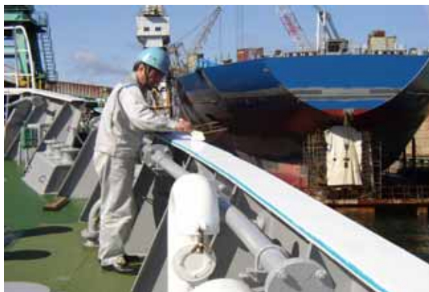
☆ブルワークトップ (塗装作業)
