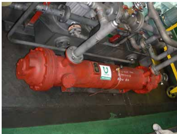
写真 8 . 潤滑油冷却器
