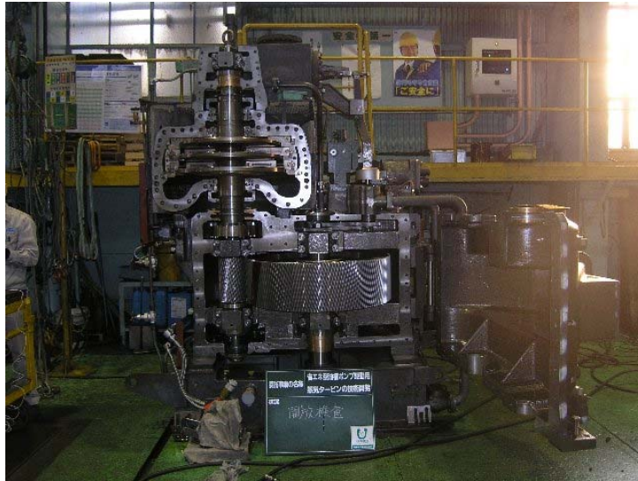
写真 38 タービンケーシングカバー・減速車室カバー取外時
