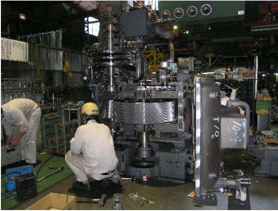
写真 32 蒸気タービン・減速機組立中
