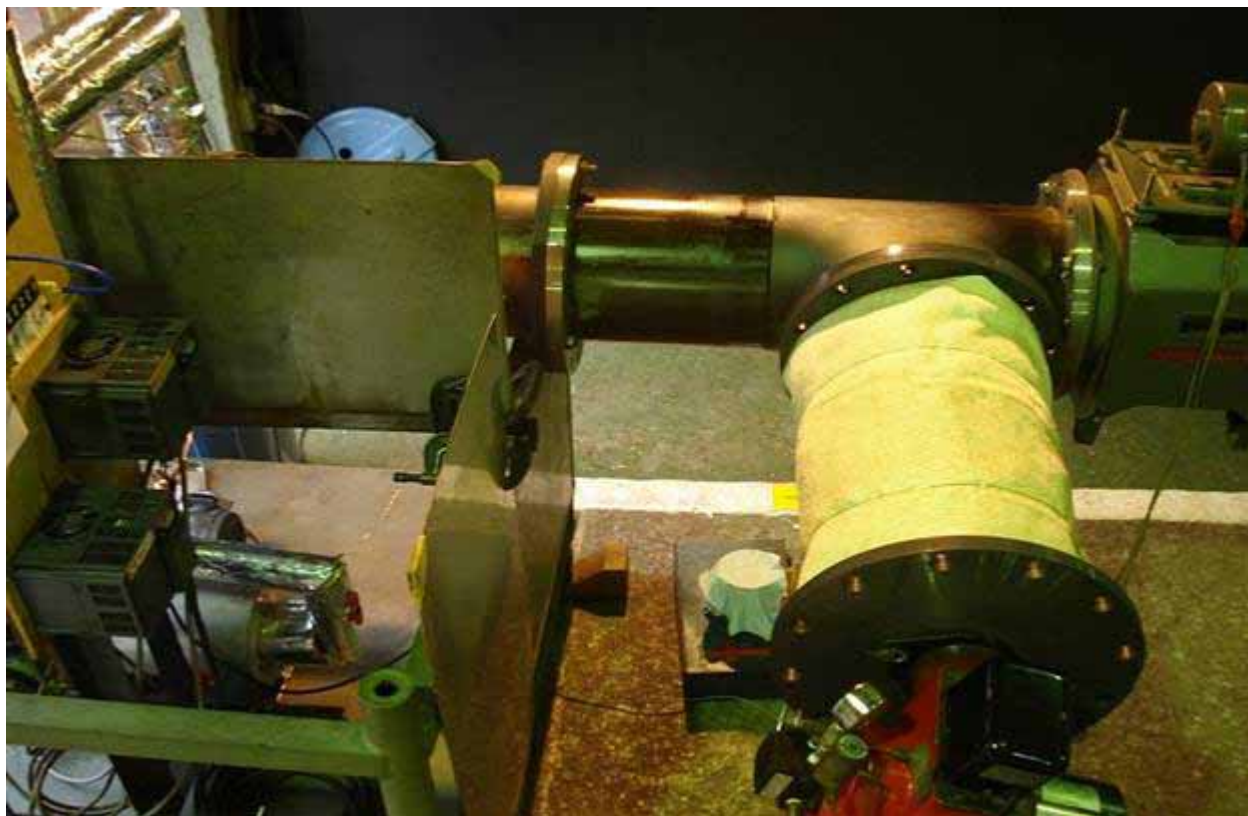
写真 3.4 バーナーの取り付けと軸流ファンの取付け
