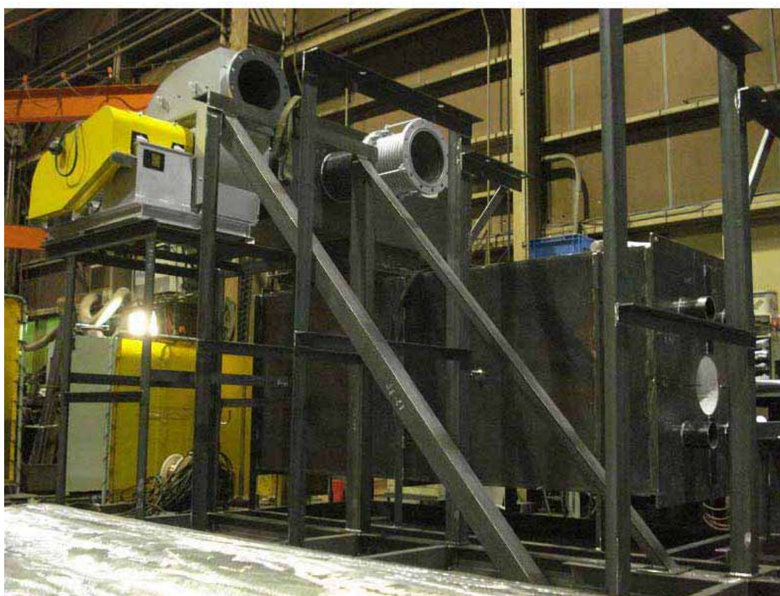
写真 3.4 燃烧炉・集合ダクト・ターボファン取付け
