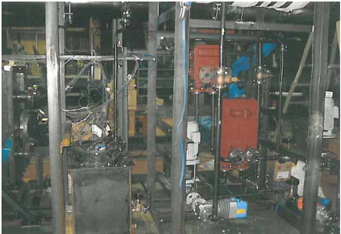
写真 3.8 配管・熱交換器・熱媒循環ポンプ・燃料油循環ポンプ据付け
