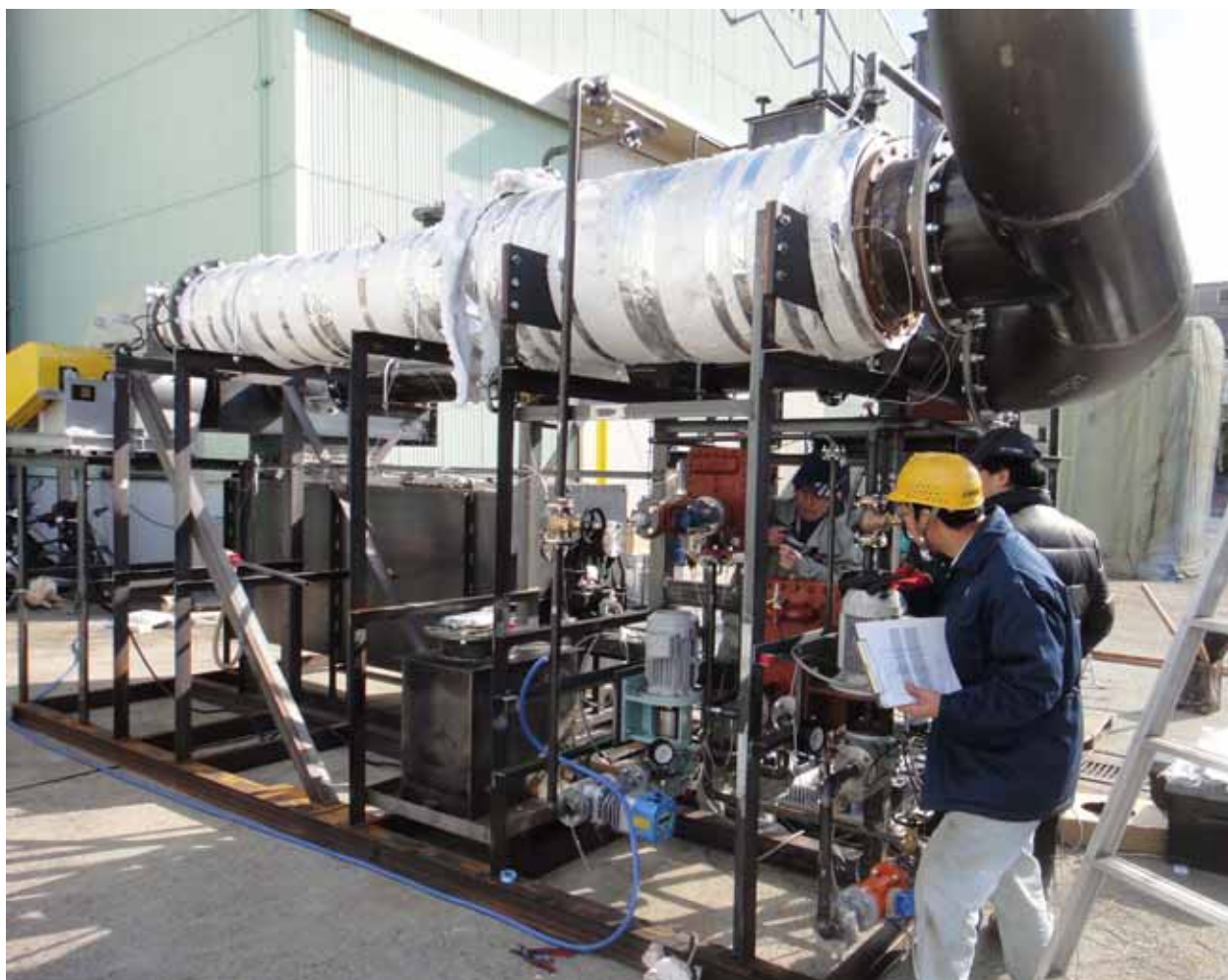
写真 3.9 計測用配線・センサー取付け
