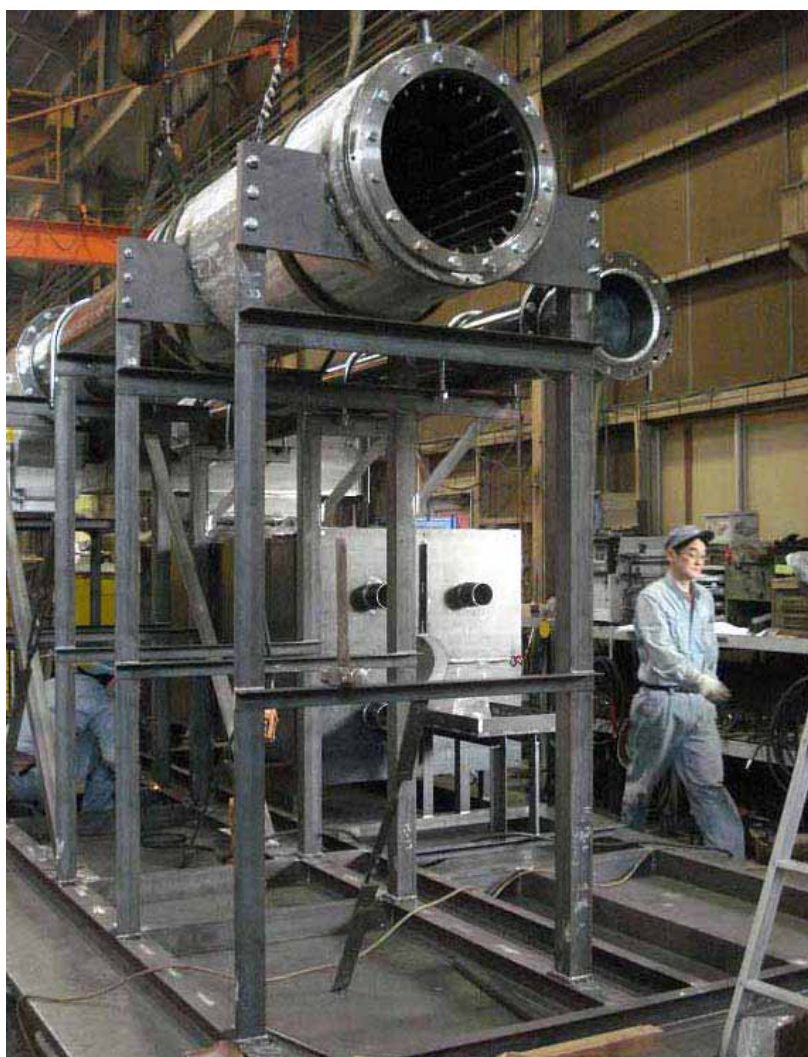
写真 3.6 排ガス熱交換器据付け時
