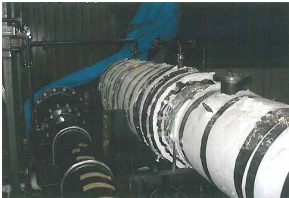
写真 3.5 排ガス熱交換器本体・計測筒防熱工事
