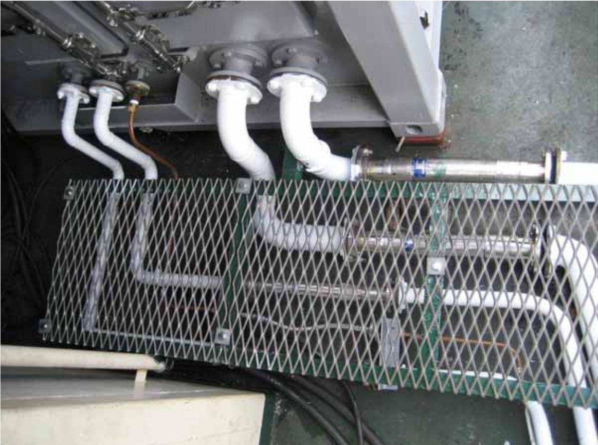
コンテナ型常用発電機装置と船体との配管取り合い部
