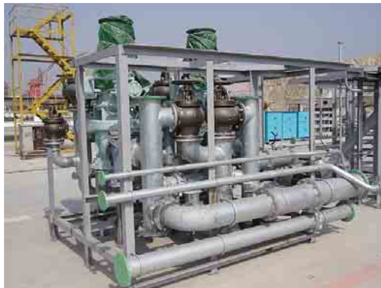
写真 2.7 E造船所 (機関室ユニット2)
