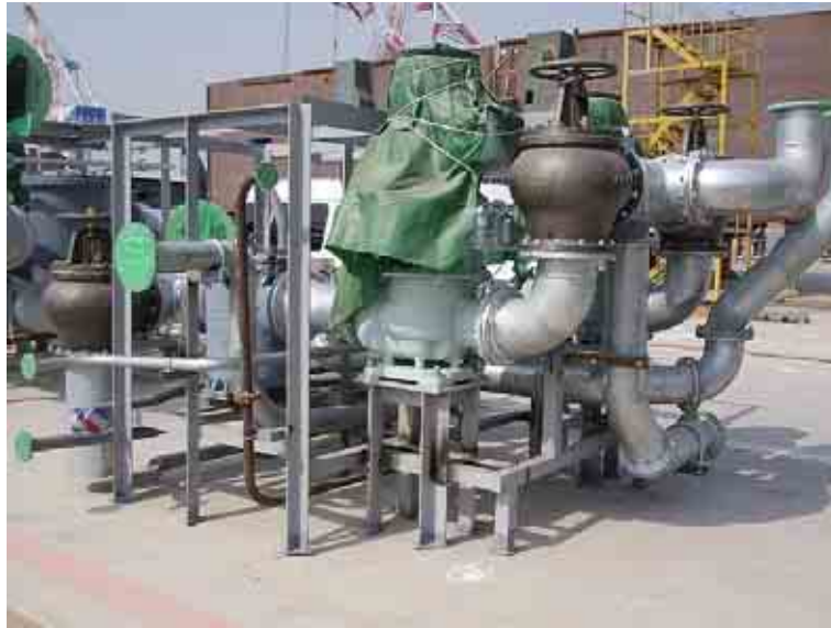
写真 2.6 E造船所 (機関室ユニット1)
