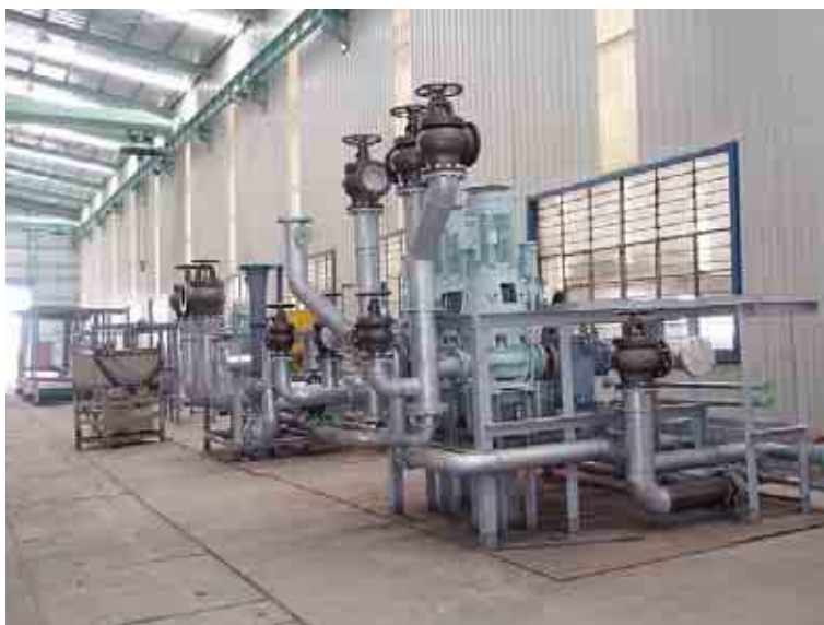
写真 2.10 E造船所（モジュール製作スペース）
