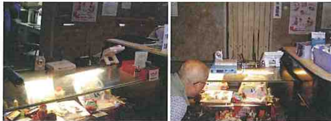
図 13 IC タグリーバ 設置の様子
