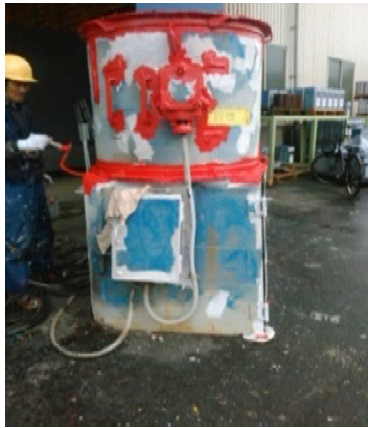
図 5-1 構内施設・設備塗装補修
