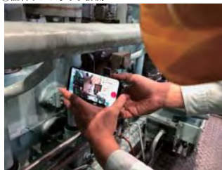
④排気用ダイヤル温度計の計測
