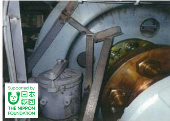
完成 船尾側より
