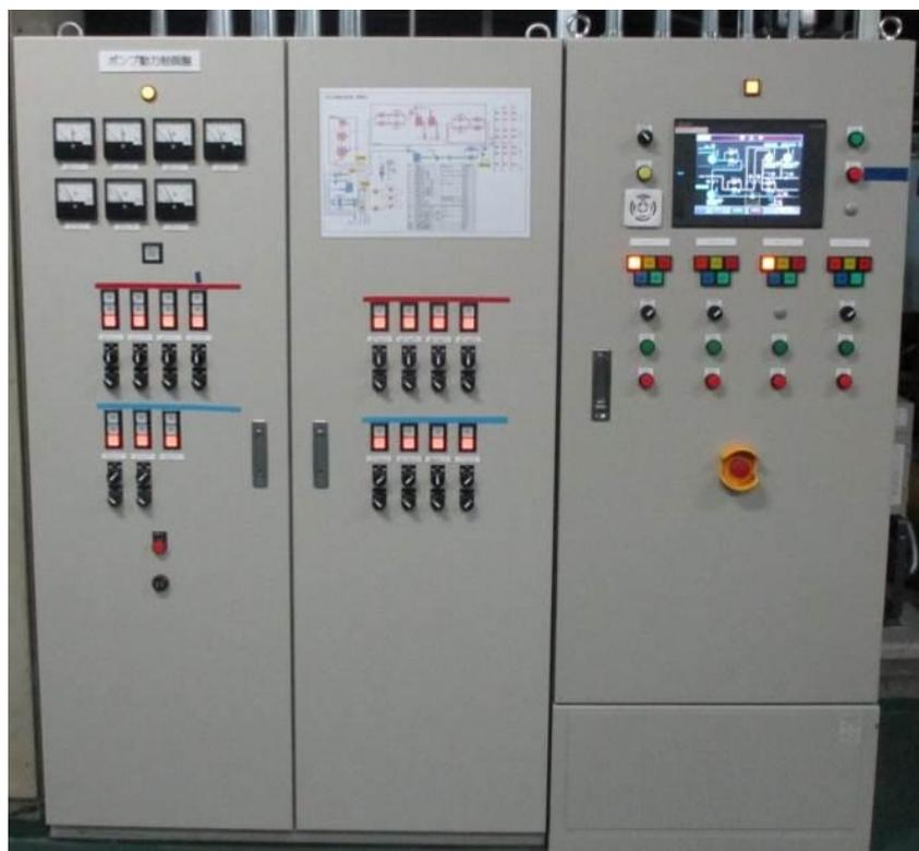
図 4. 2. 3-5 軽油/水消費量計測用制御盤
