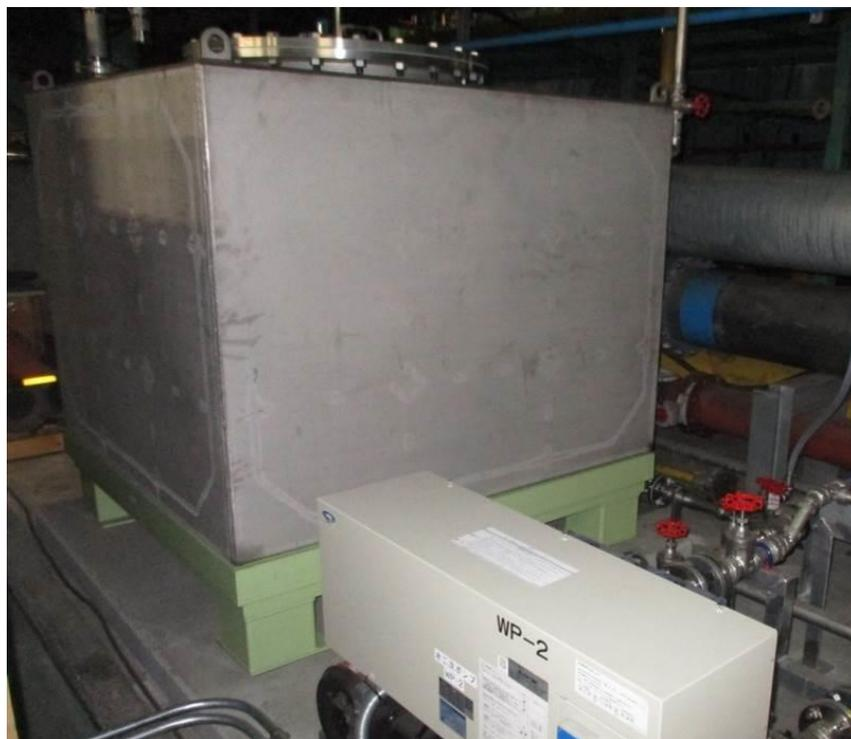
図 4. 2. 3-3 水消費量計測用タンク
