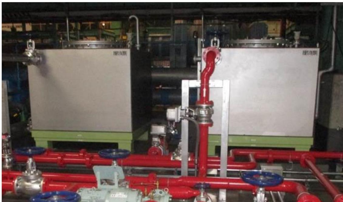
図 4. 2. 3-4 軽油消費量計測用タンク
