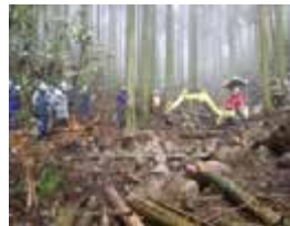
洗い越し施工
