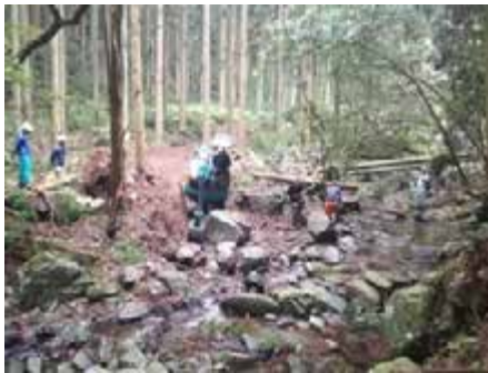
川渡及び作業道開設
